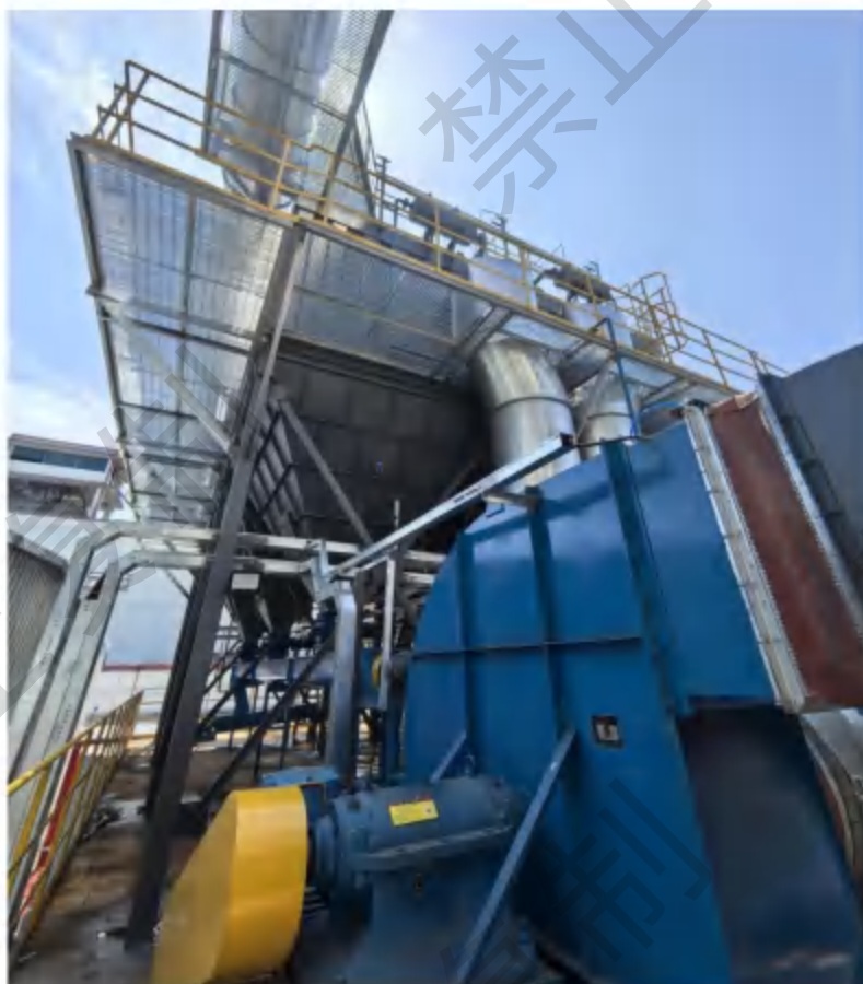
图 4-7 袋式除尘装置
