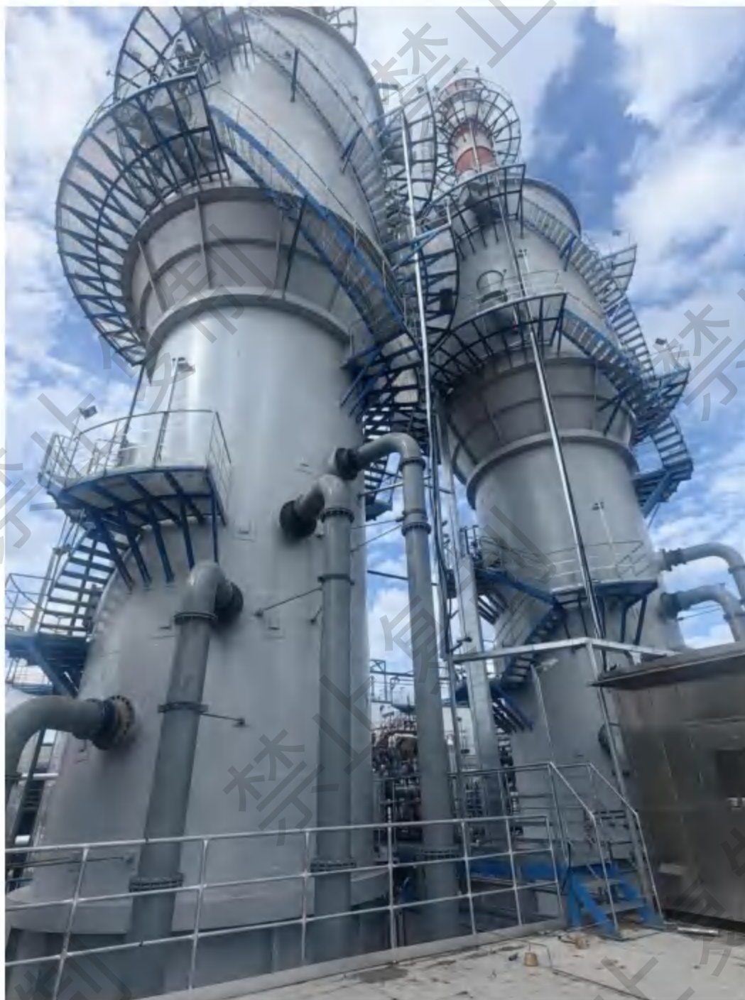
图 4-5 湿法脱硫+湿电除尘装置
