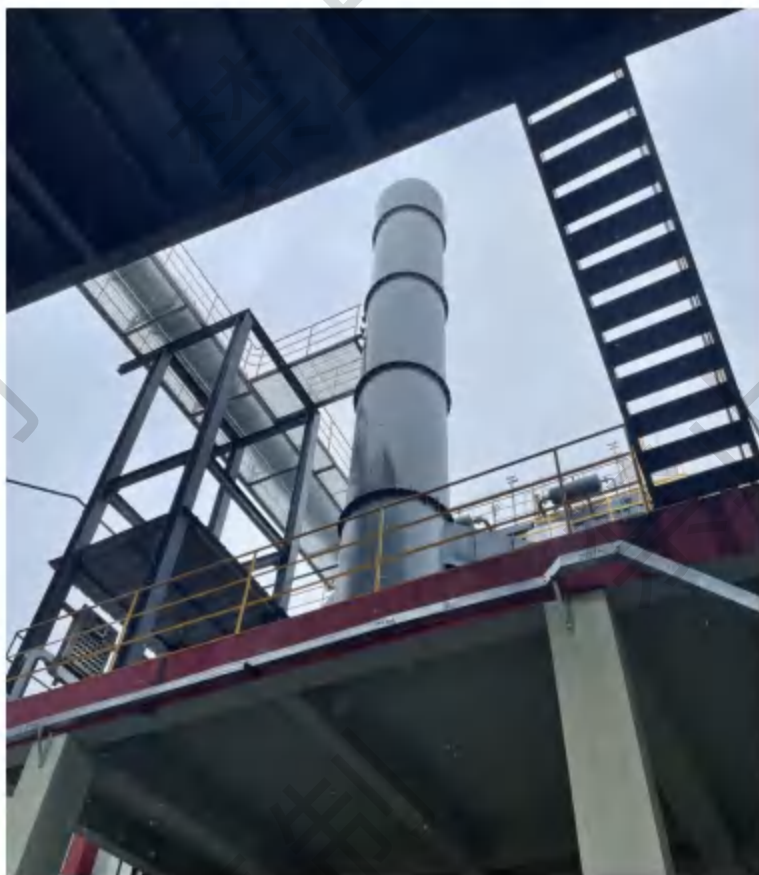
图 4-7 袋式除尘装置
