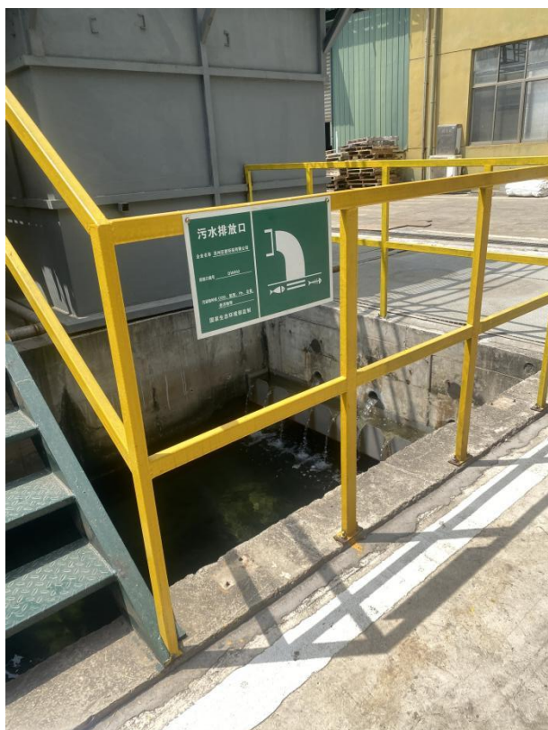
(污水排放口标识牌)
